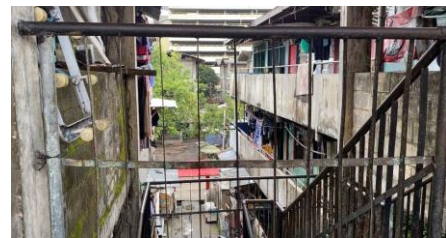
Gambar 1. Kondisi bangunan rumah susun
